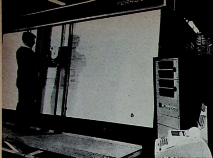
Meettafel van Ferranti voor het uitmeten van tekeningen. Meetoppervlak 3048 x 1524 mm bij een nauwkeurigheid van 0,127 mm.
